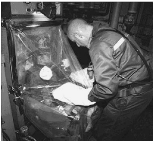
Bild 3: Entfernung der Dichtungen an den Reinigungsöffnungen der Rauchgaszüge
