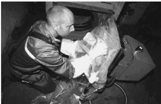
Bild 2: Entfernung der Brennertürdichtung
